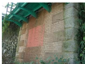
中央線多摩川鉄橋の橋台
