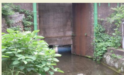
日野煉瓦でできた橋台
