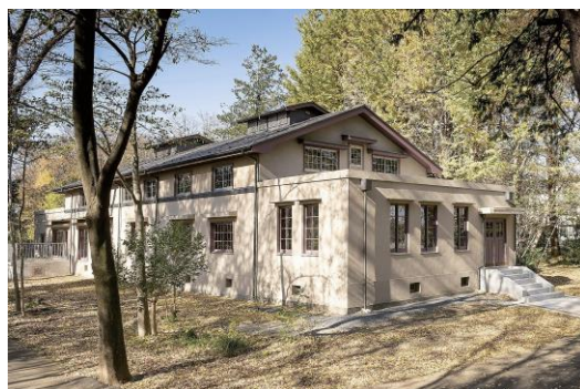
保存修理工事がなされた第一蚕室
