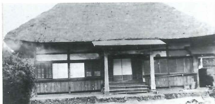
校舎に使われた善生寺本堂(明治7年頃)
