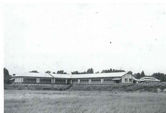
現在地へ新築(昭和17年)
