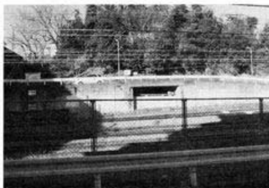
現場遠景（中央線を挟んで南側より）
