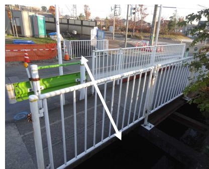
小高田橋(平成 25 年)
