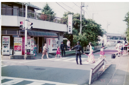
地蔵店があった頃の地蔵橋(平成7年)
