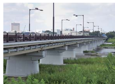
復旧した日野橋
