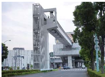
下から見たレールの終わり 多摩センター駅
