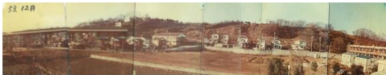
昭和53年12月 小学校建設中の風景
